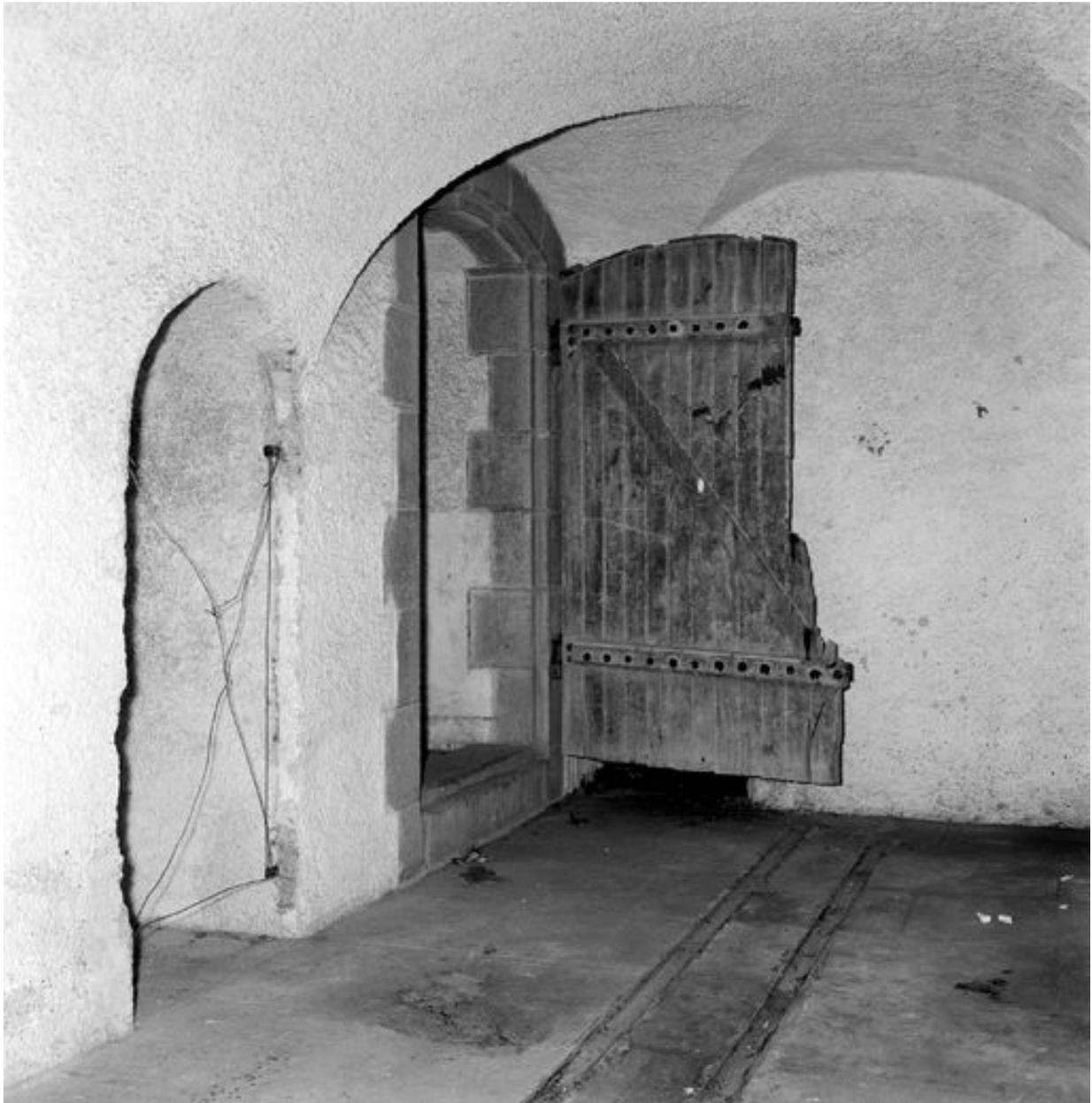
Vue de la batterie du Toulinguet en 1969 : vestibule d'entrée du magasin à poudre sous roc. A gauche : entrée de la galerie enveloppe, au centre : magasin. A signaler : huisserie en place
