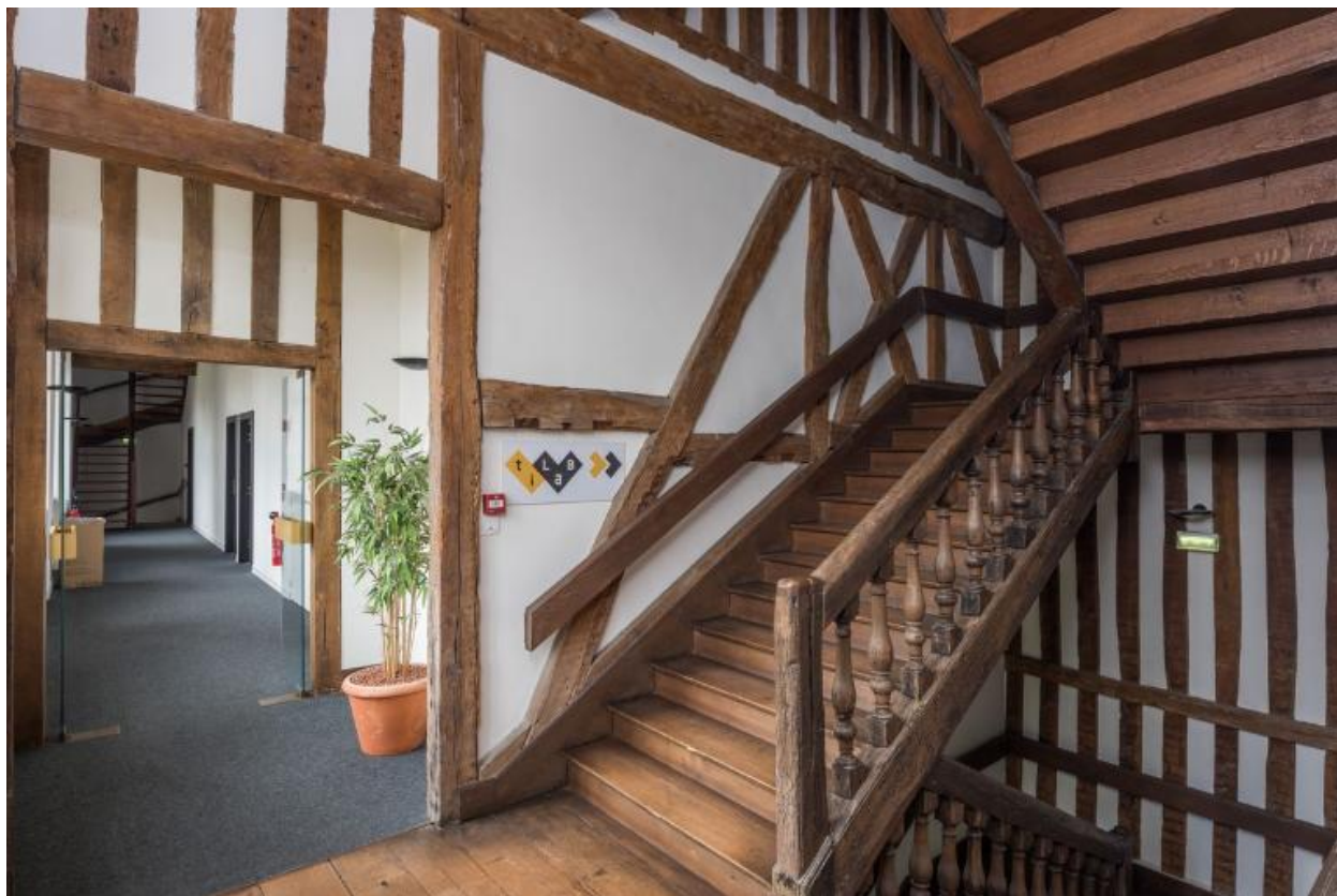
Intérieur, cage de l'escalier central en pan de bois
