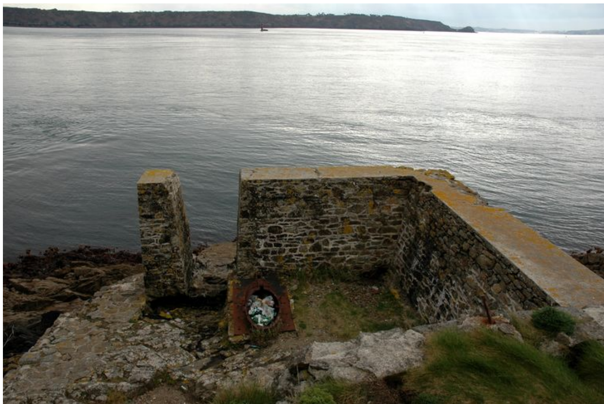
Vue du tube de lancement (état en 2006)
