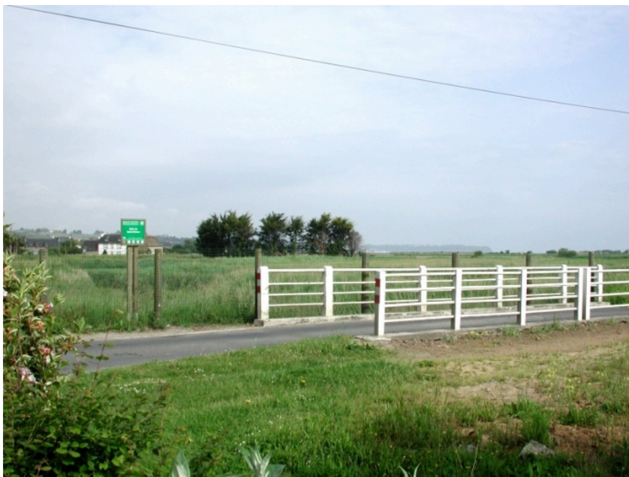
Pont de la rivière d'Yffiniac
