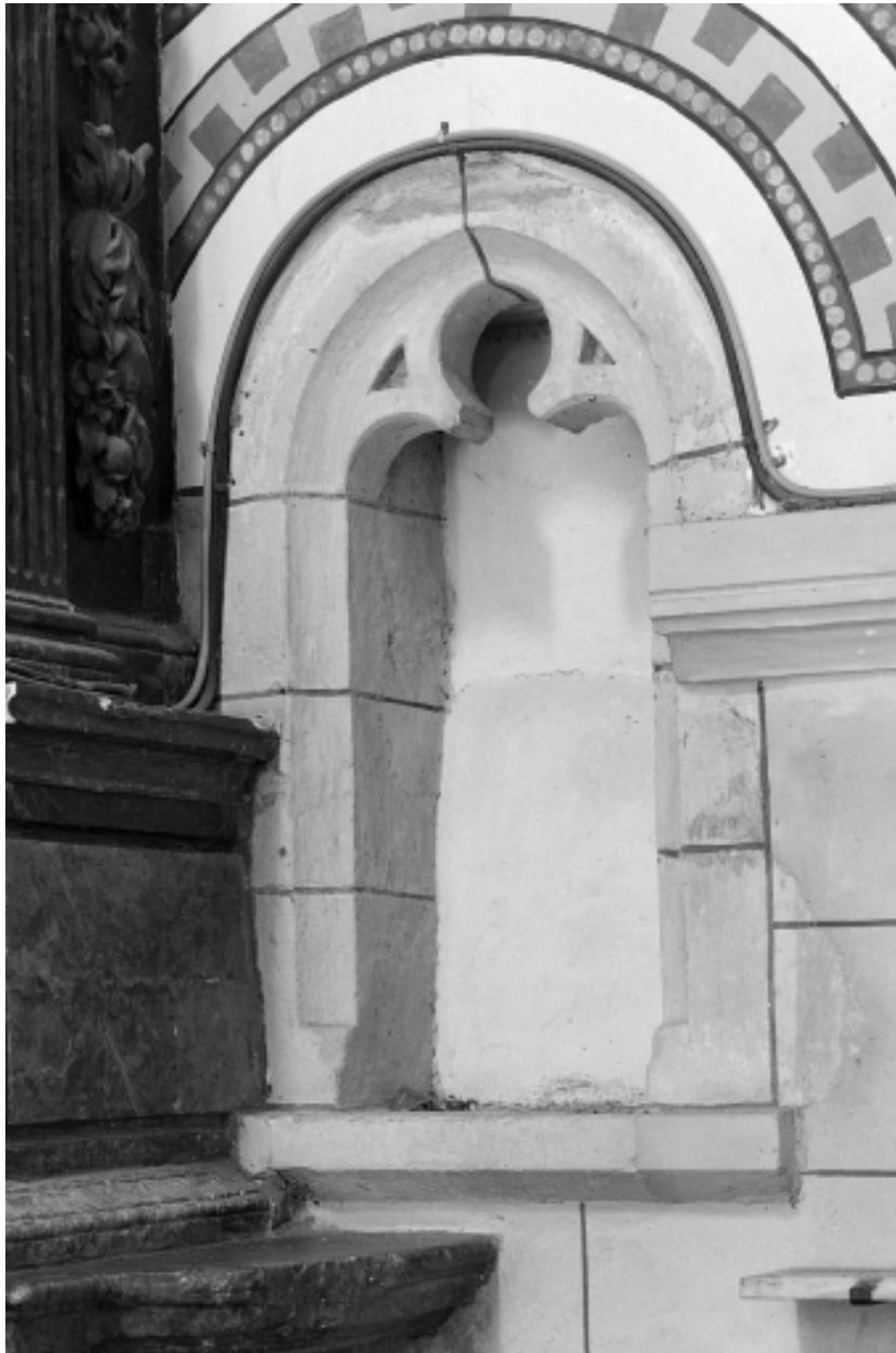
Choeur, crédence, mur sud.
