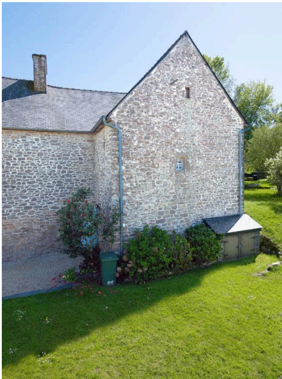
L'avancée nord, vue depuis la rue de la Commanderie.
