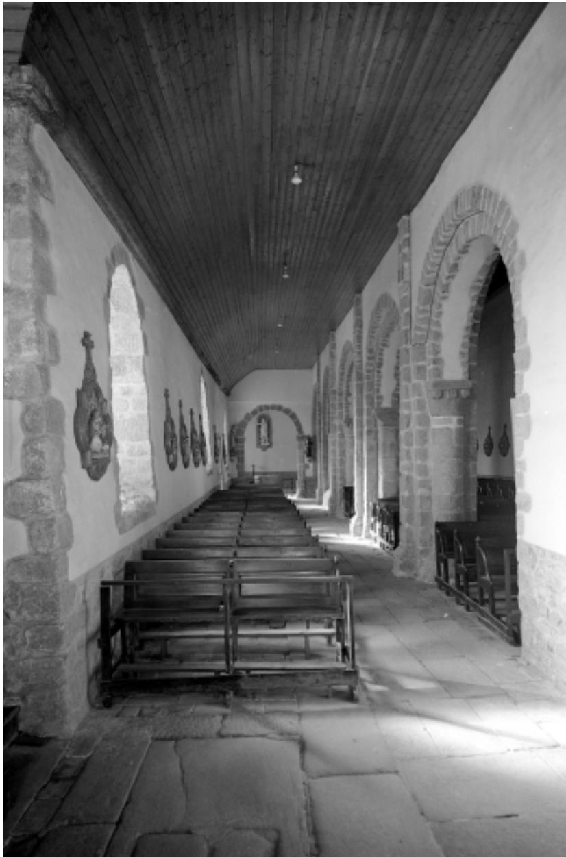
Intérieur, bas-côté : vue générale d'Est en Ouest.
