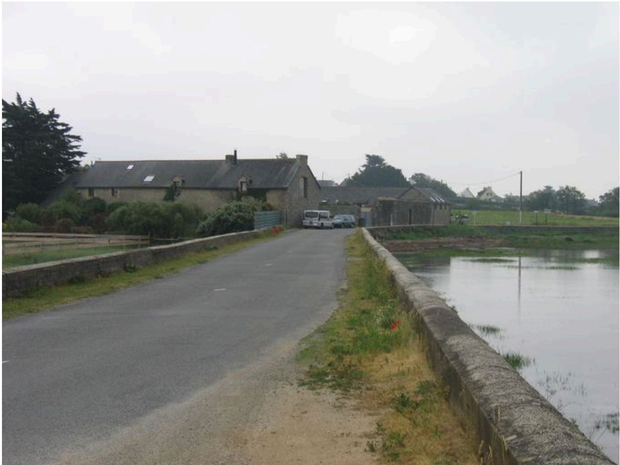
Vue générale de la digue-route d'Herbon
