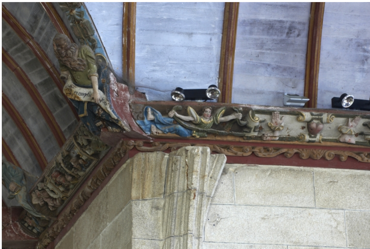
Intérieur, mur nord du choeur, détail de la sablière et du blochet
