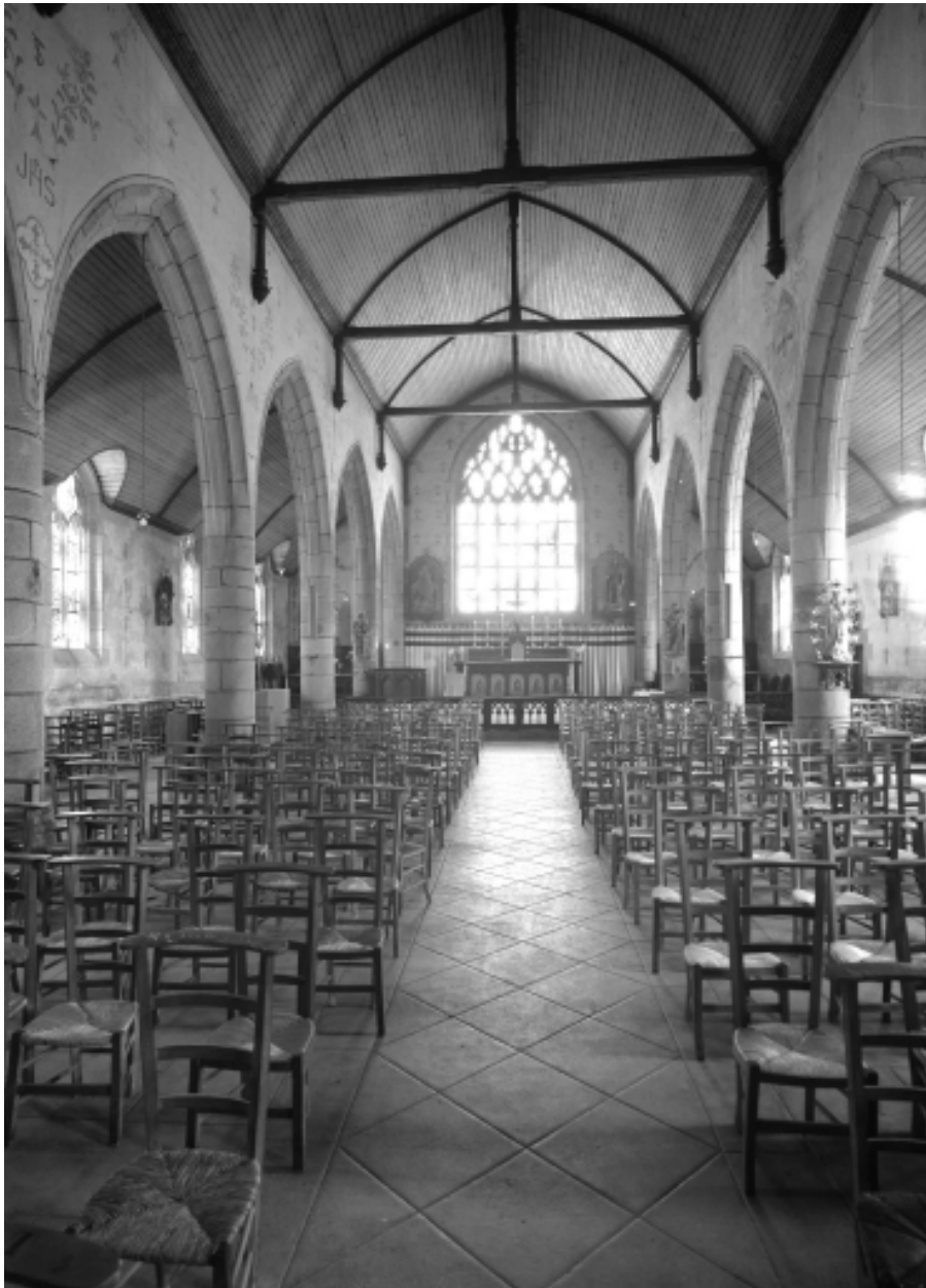
Landeleau, église paroissiale Saint-Théleau : vue axiale est, état en 1966
