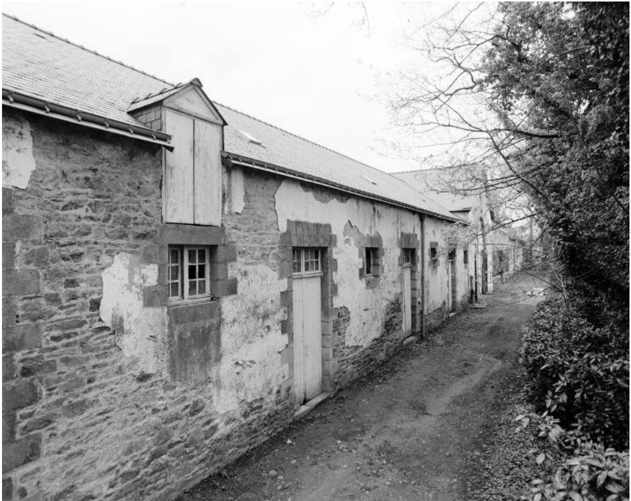
Cour nord, communs ouest, élévation est.
