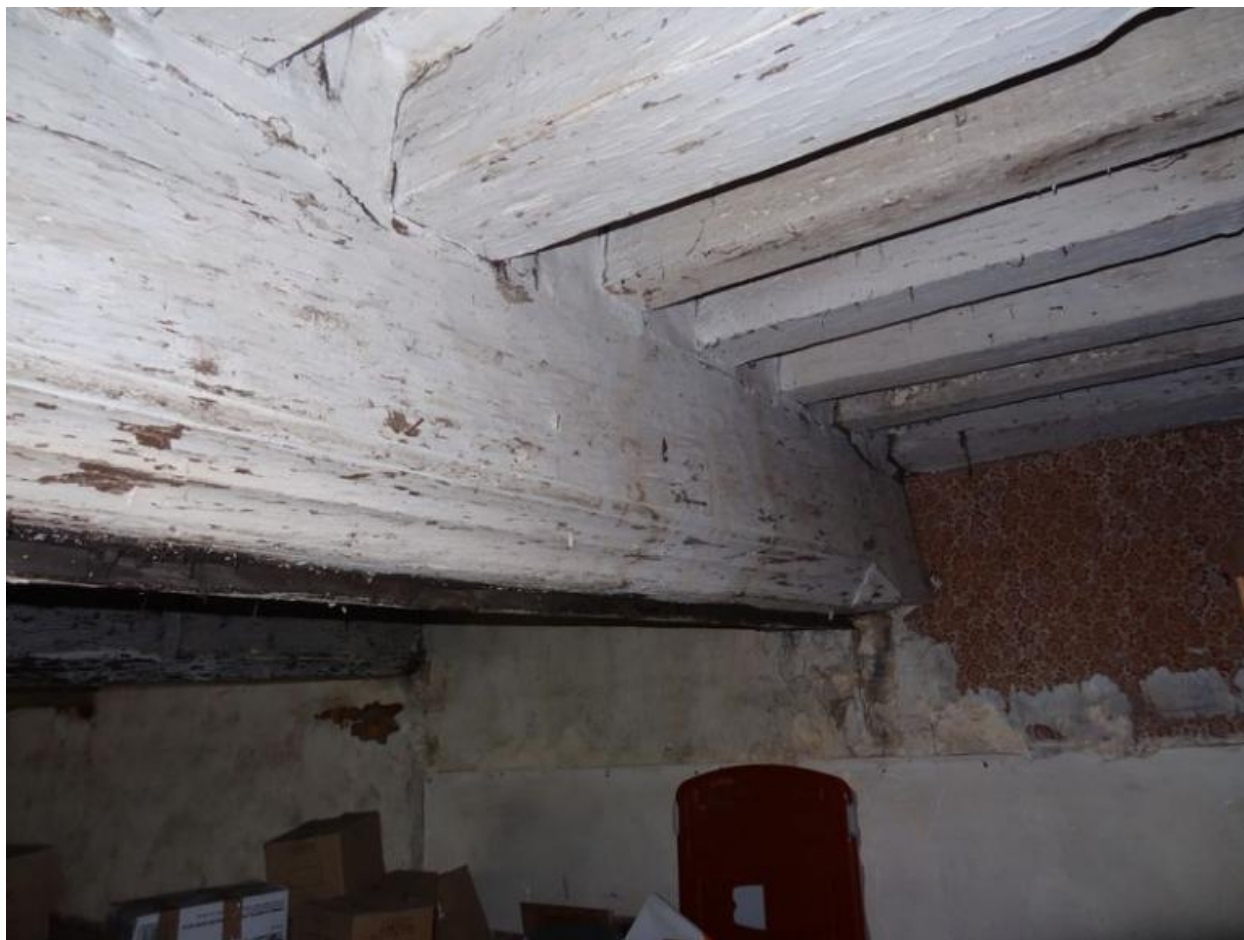
Plafond du rez-de-chaussée
