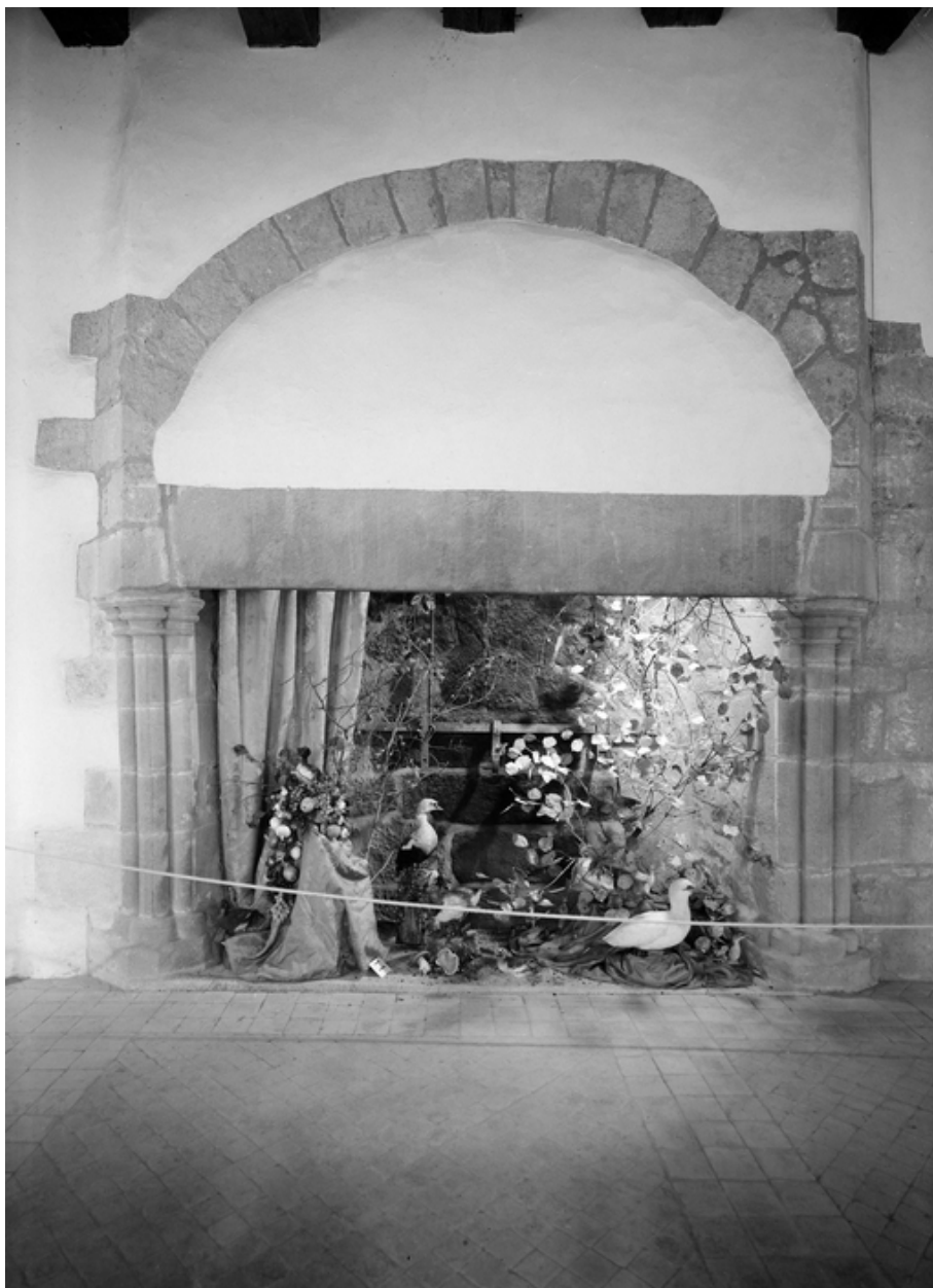
Vue de la grande salle au premier étage : détail de la cheminée (état en 1974). Ses piédroits sont ornés de colonnettes à petits chapiteaux et bases en flacon soulignées d'un listel
