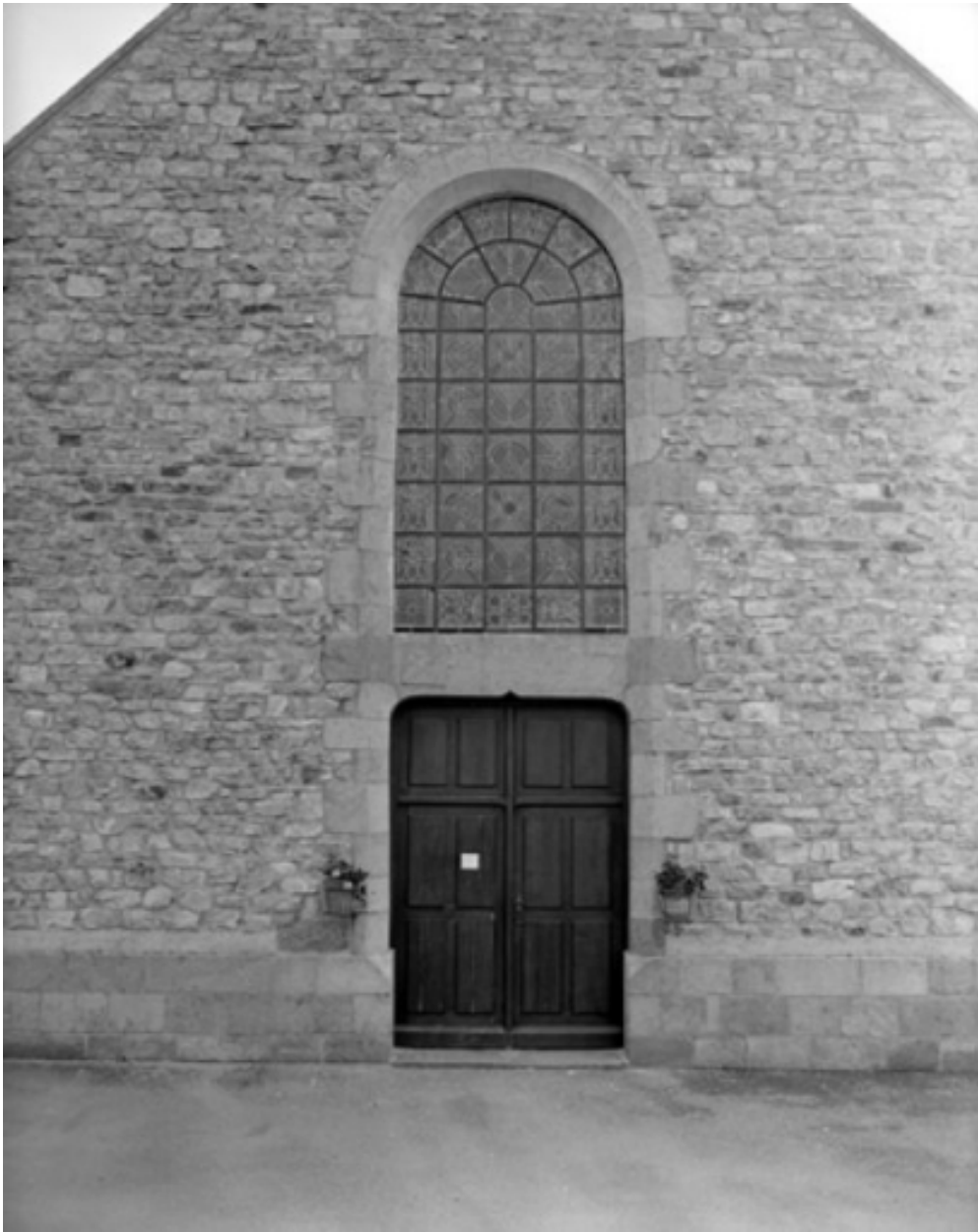
Élévation Ouest, porte : vue générale
