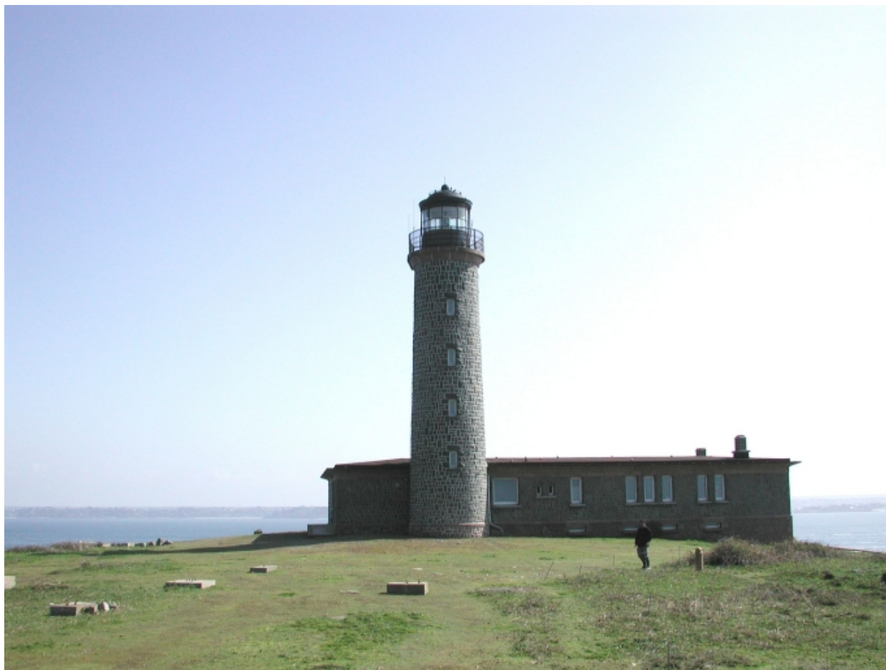
Vue générale : façade ouest
