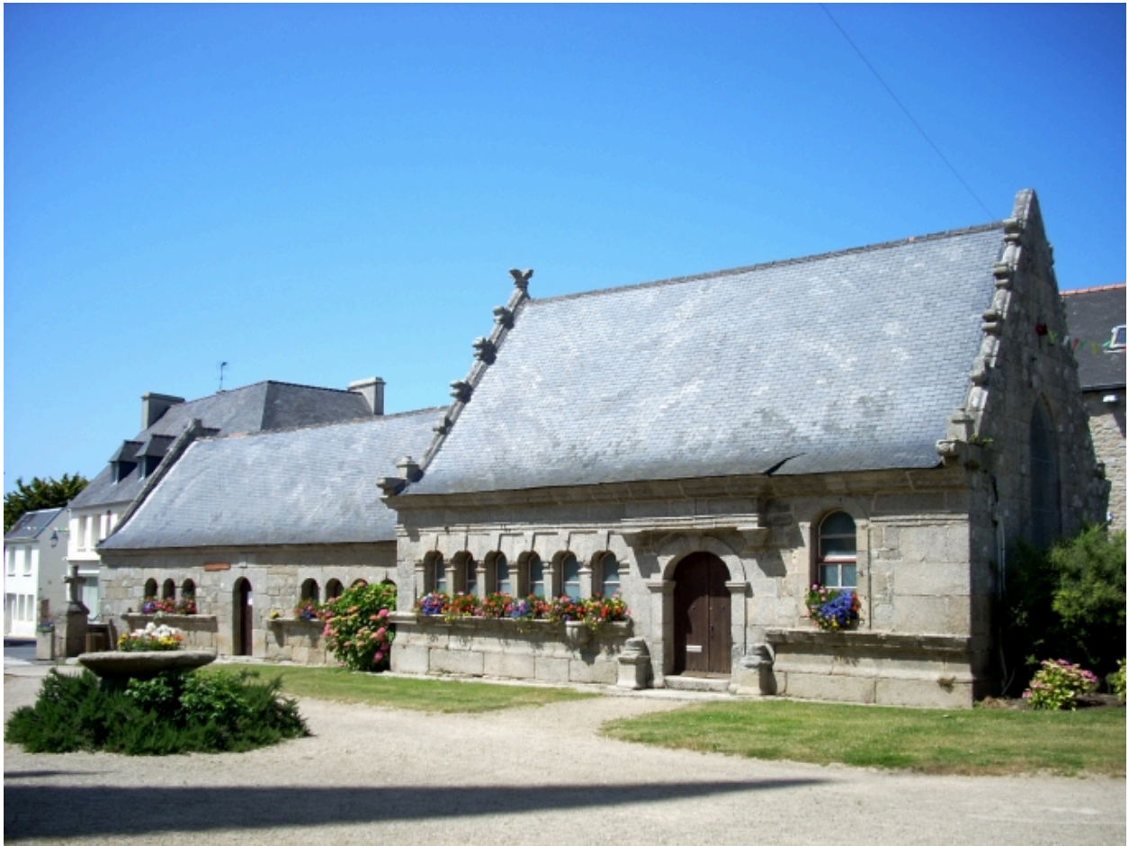
Plounéour-Trez, église paroissiale : vue générale sud-est des ossuaires
