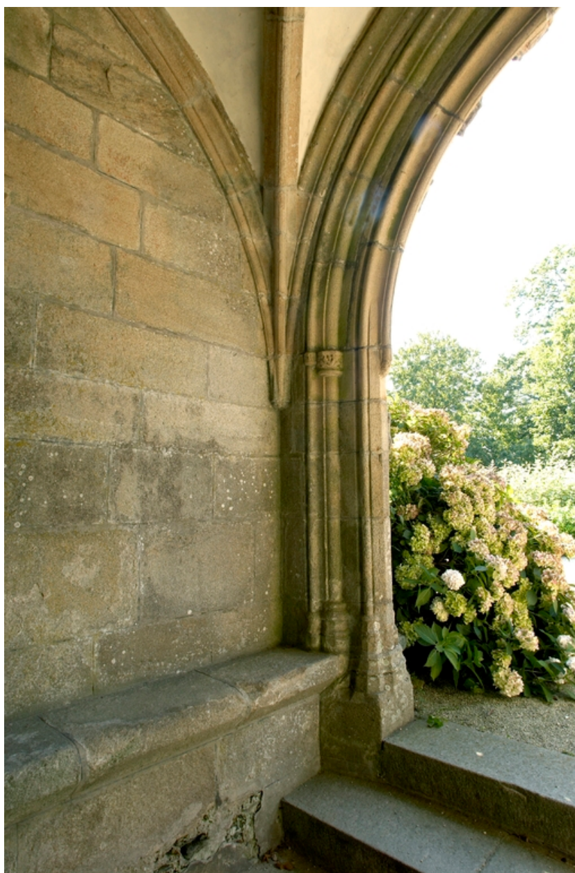
Porche sud, détail du revers de l'arc d'entrée
