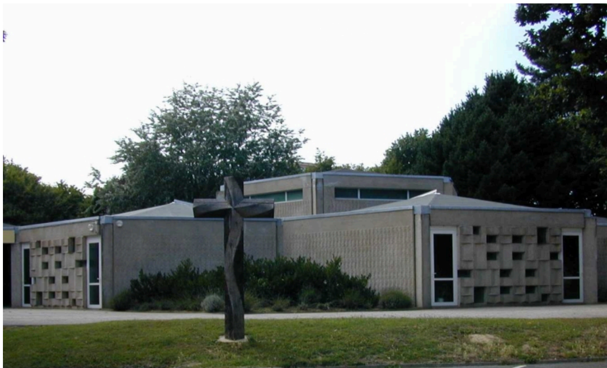
Détail de la façade est
