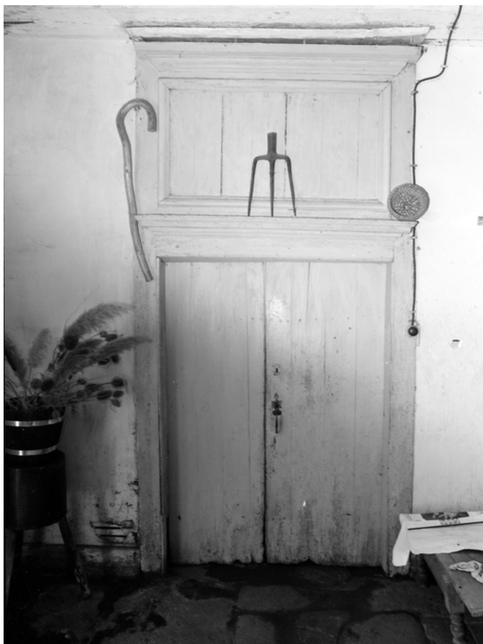
Intérieur, rez-de-chaussée : porte ouest.
