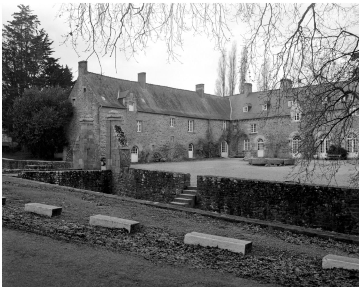
Vue générale de l'aile Ouest.
