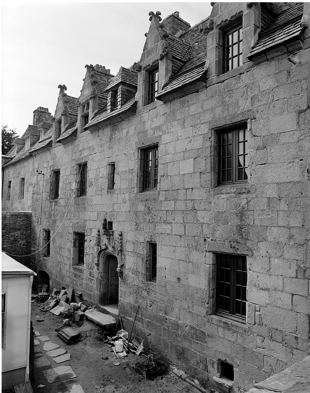
Elévation est, vue générale
