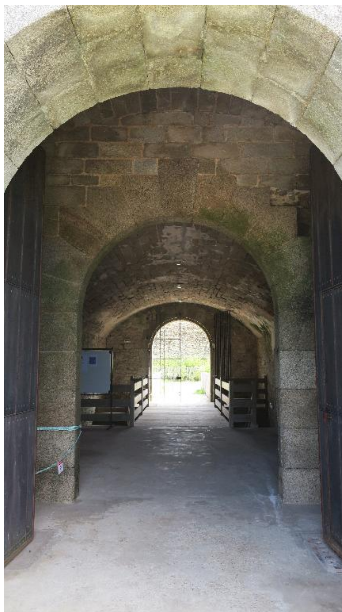
Hoedic, fort central, caserne à l'épreuve, porte.
