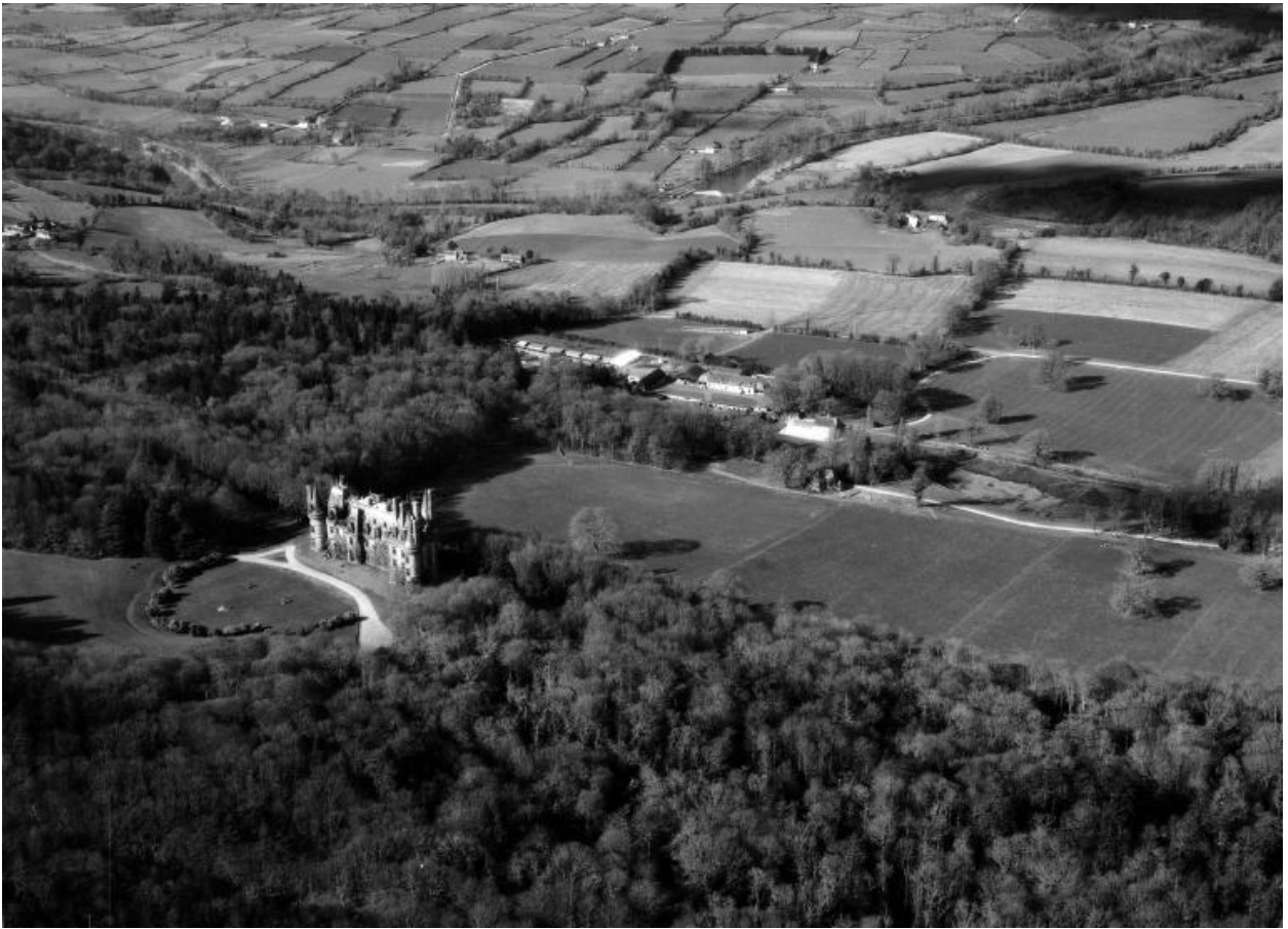
Vue aérienne de situation de l'ensemble du parc, prise du sud-est
