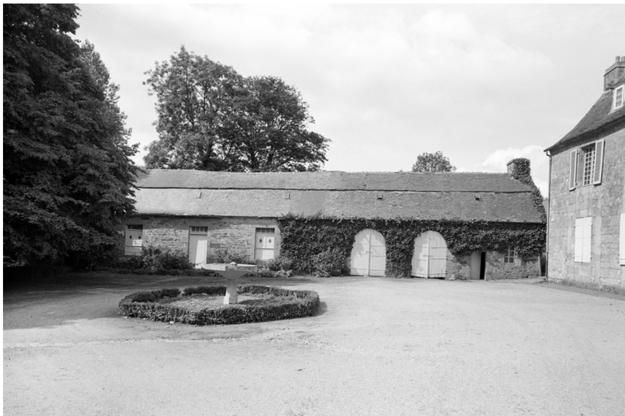
Aile sud : élévation nord est
