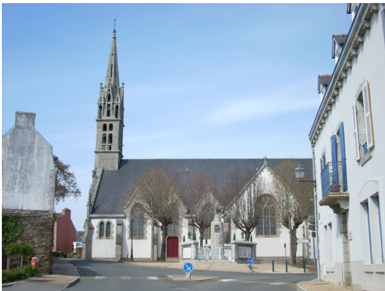
Concarneau, Beuzec-Conq, église Saint-Budoc : vue générale sud
