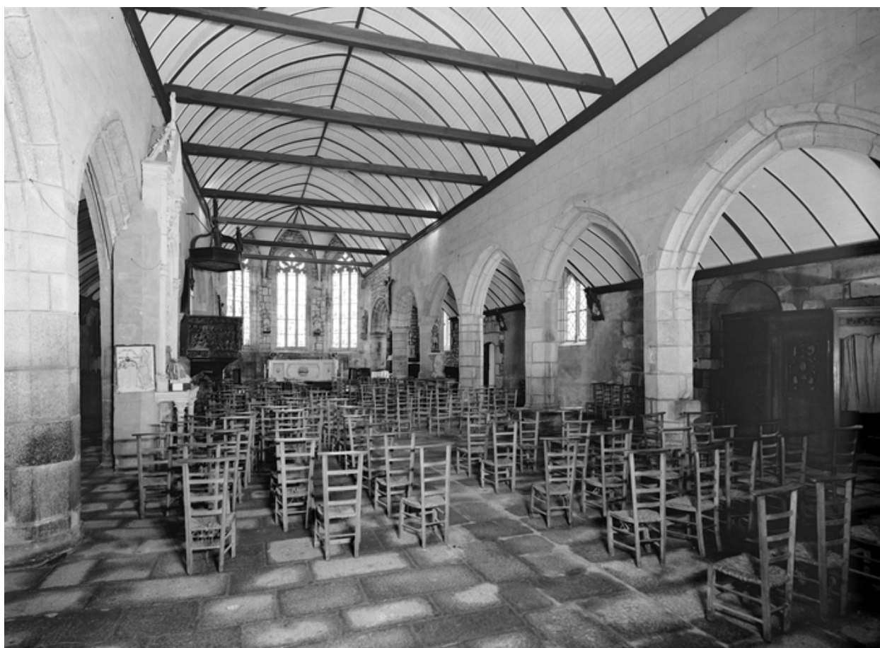
Nef : vue générale sud est
