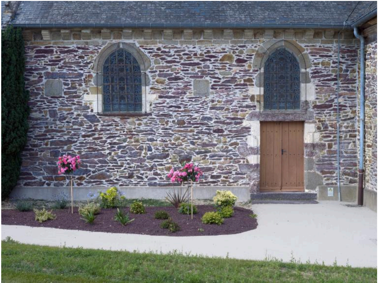
Vue extérieure du collatéral sud
