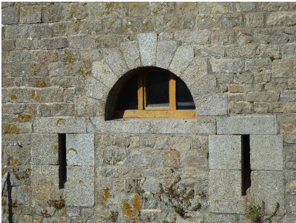
Île-d'Houat, batterie d'En Tal, corps de garde crénelé, détail d'une baie et de créneaux de tir.
