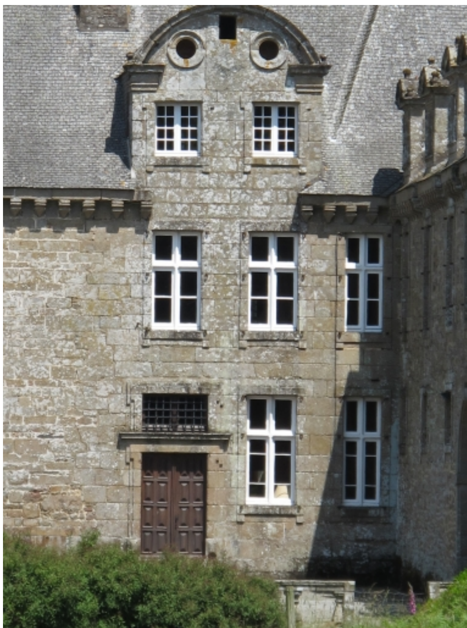
Détail des ouvertures, façade principale
