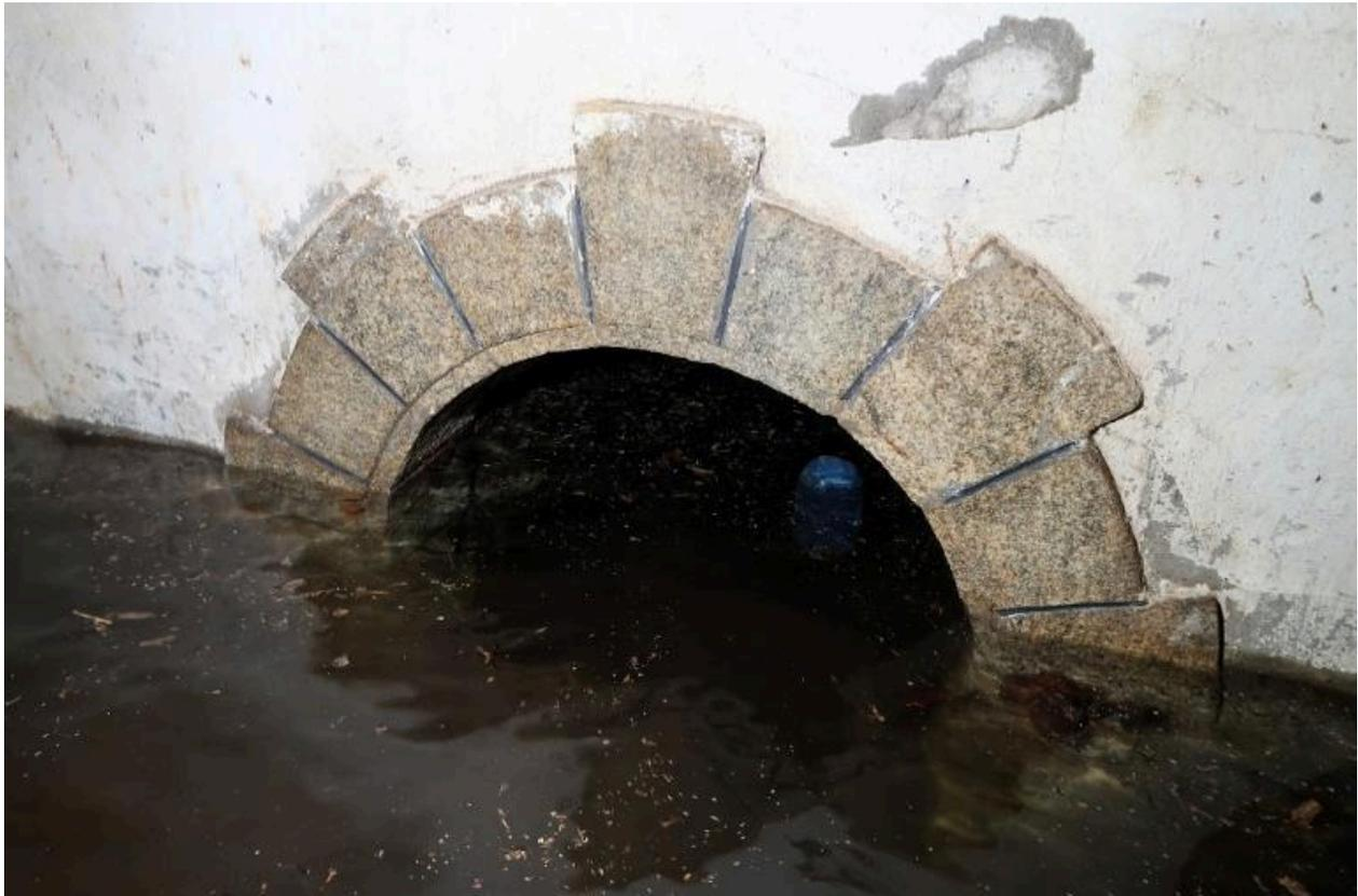
Vue de l'aqueduc dans le vestibule côté escalier. Le magasin est inondé : l'eau ne s'évacue pas totalement car l'aqueduc est partiellement bouché en aval
