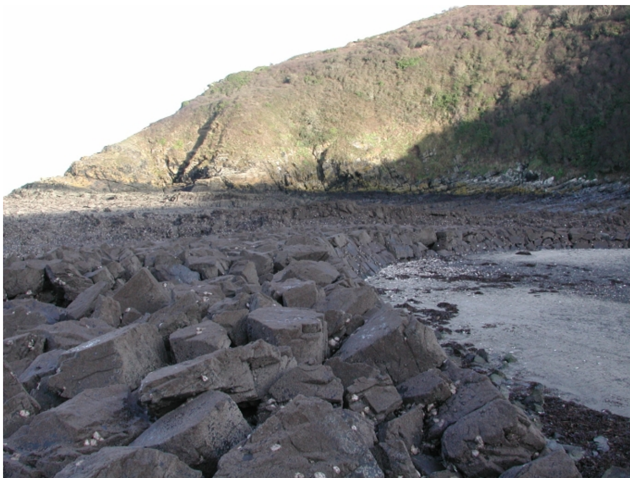
Vue de la digue et du sillon naturel des Roches-Blanches
