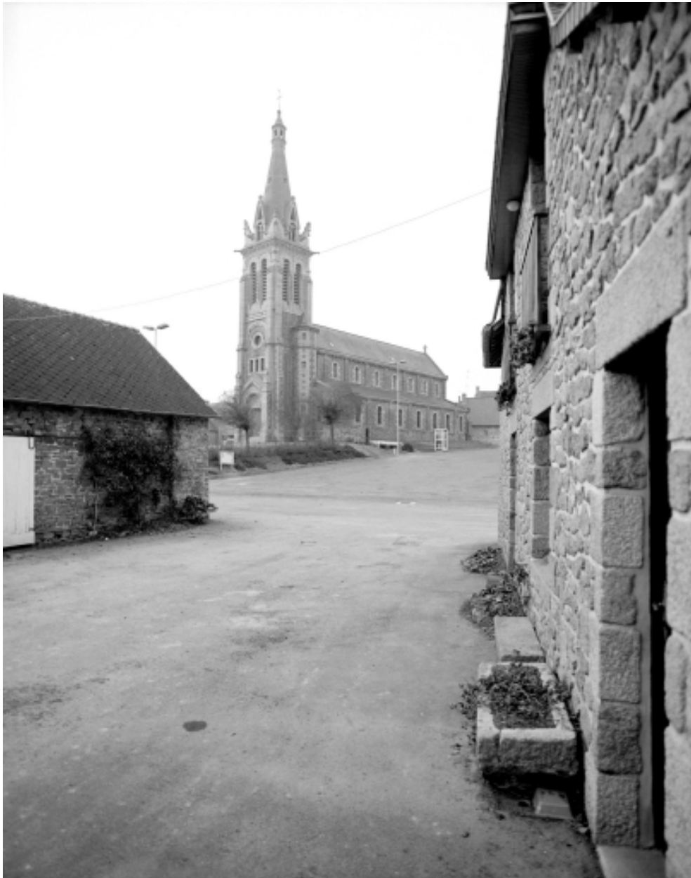
Elévation Sud-Ouest : vue générale
