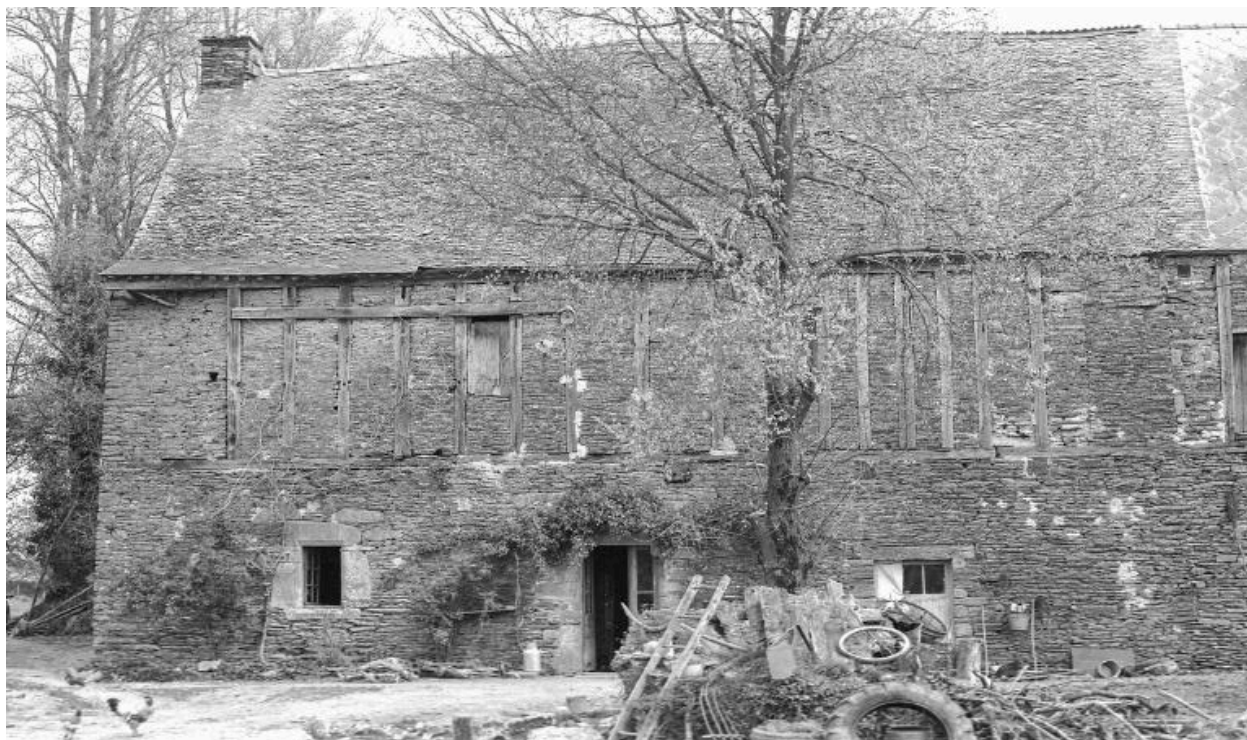
Logis, élévation ouest (état en 1974)
