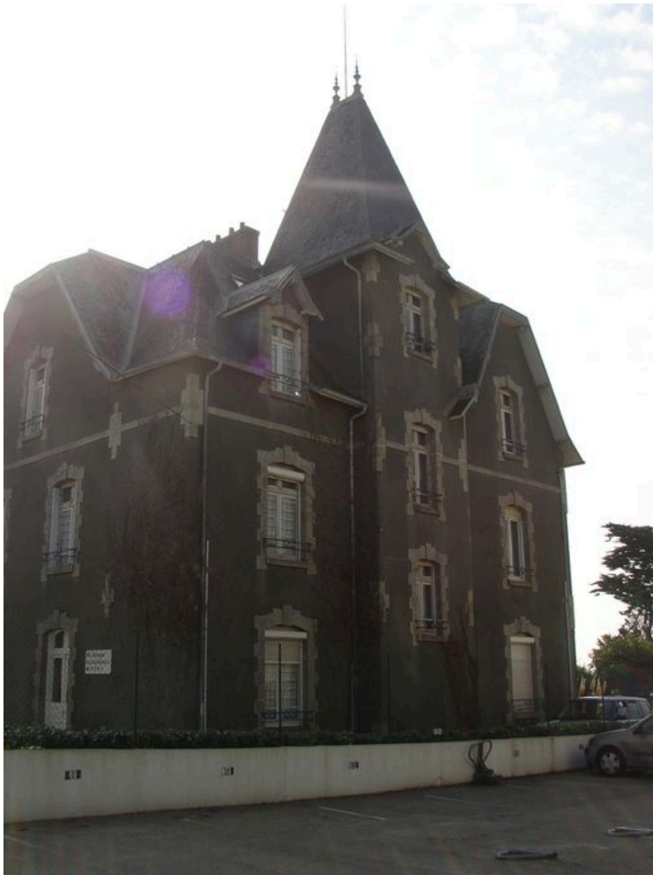
Façades ouest et nord de la villa Kerbugalé
