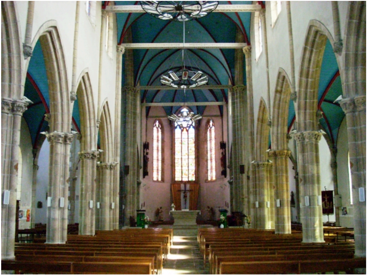
Église paroissiale : vue axiale est (état en 2008)
