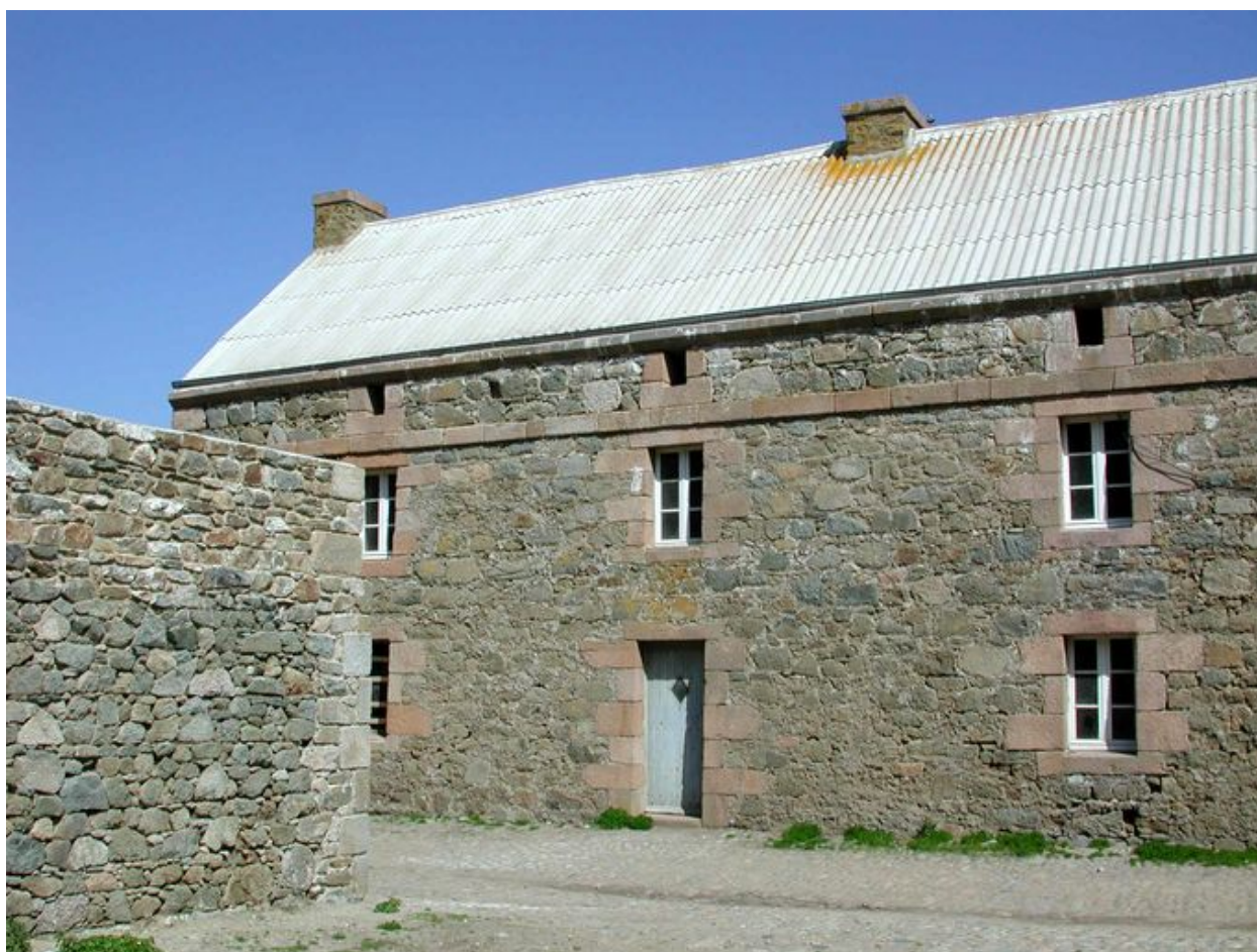
Vue de l'élévation sud (état en 2002)
