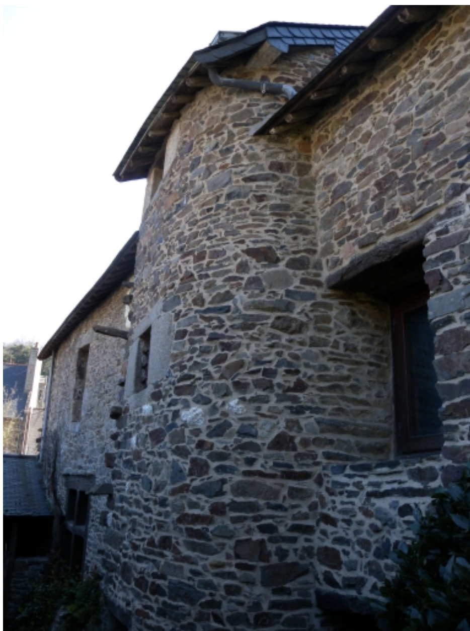
Vue de la tourelle extérieure édifée en schiste avec les ouvertures en pierre de granite
