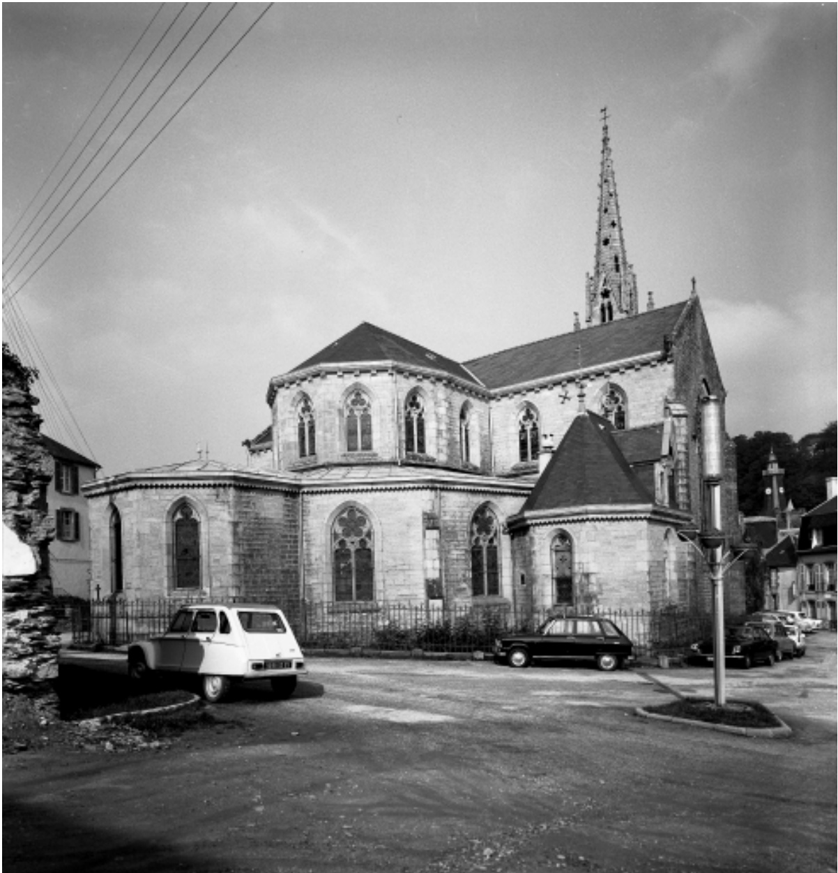
Châteaulin, église paroissiale Saint-Idunet : chevet, vue d'ensemble prise du nord-est, état en 1972
