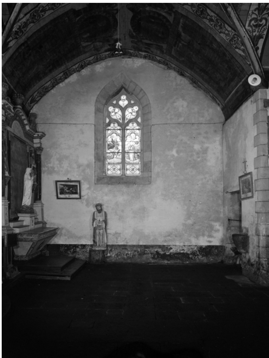
Bras sud du transept, vue axiale nord-sud.
