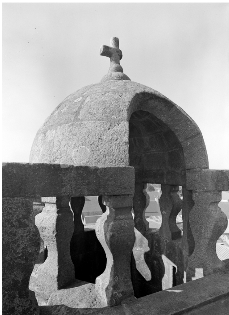
Ouverture de la tourelle du clocher
