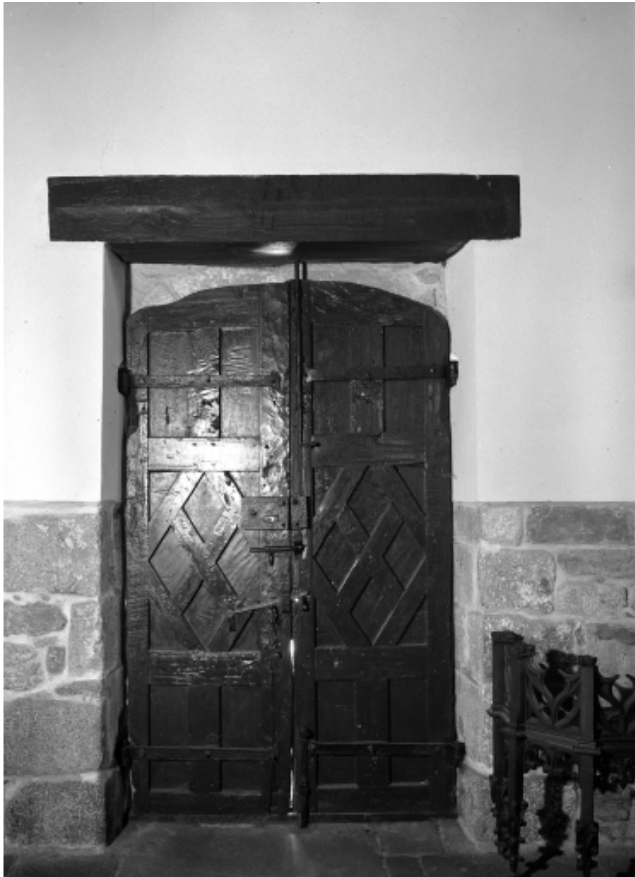
Plomodiern, église paroissiale Saint-Mahouarn : porche sud, vantail de la porte, état en 1970
