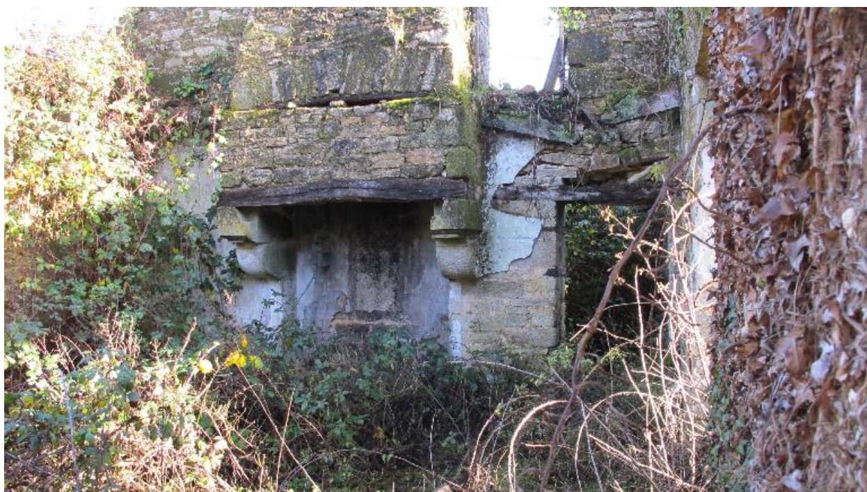
Ferme modèle, logis, cheminée du pignon est, état en 2015
