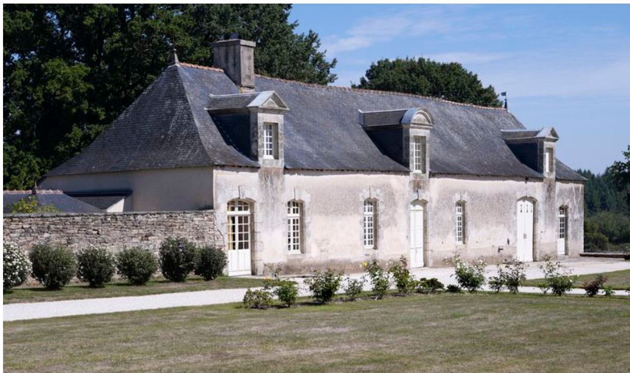
Château, dépendance nord : élévation sud vue du sud-ouest (état en 2010)
