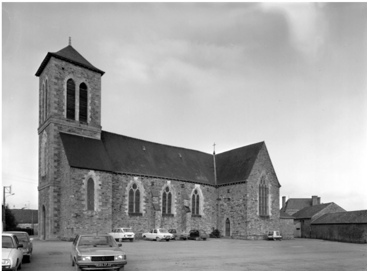
Elévation sud-ouest : vue générale
