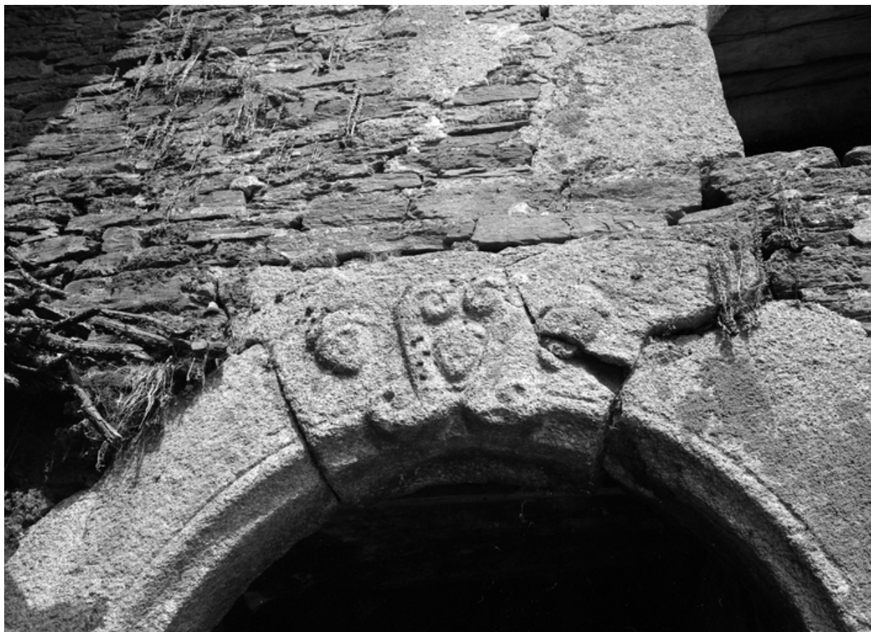
Vue sur le linteau d'une porte
