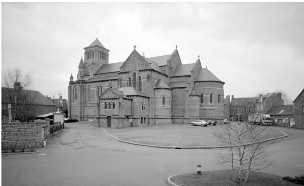
Elévation Sud-Ouest : vue générale
