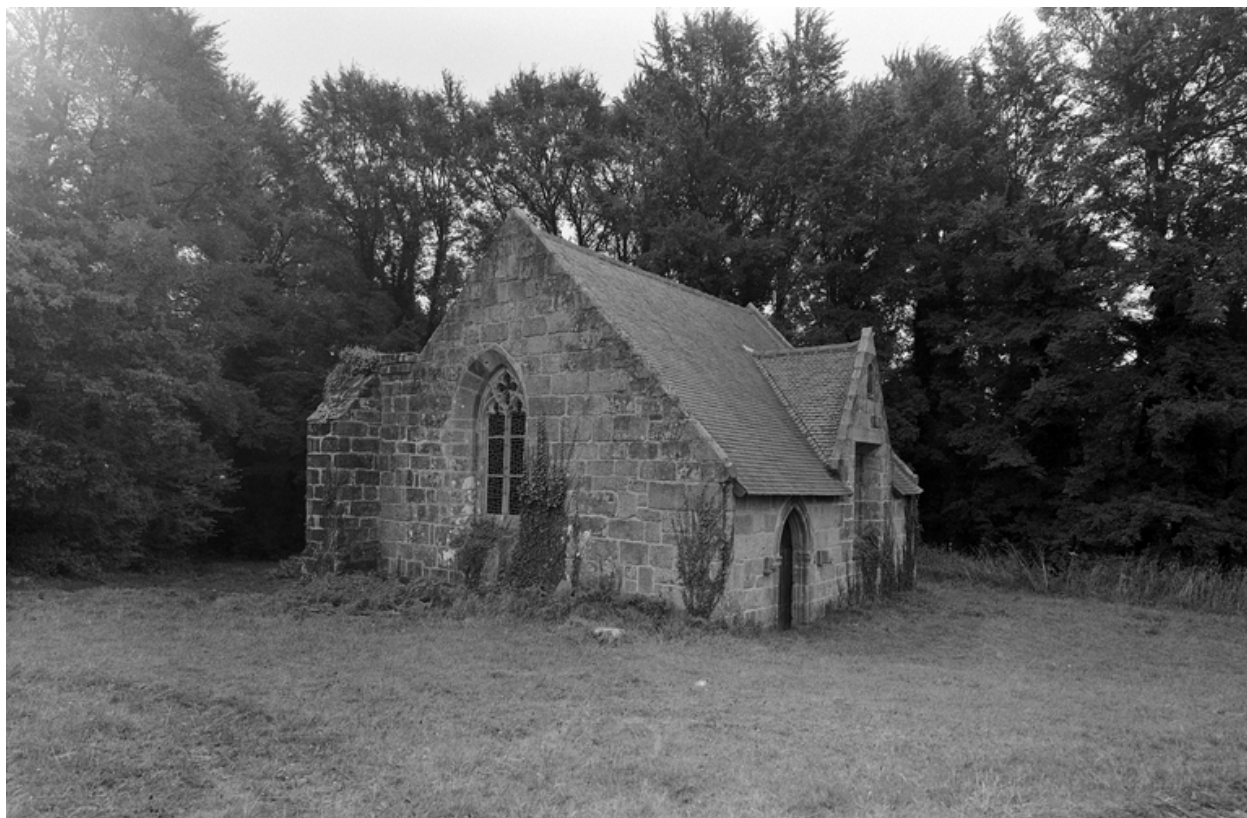
Vue de situation prise du nord ouest
