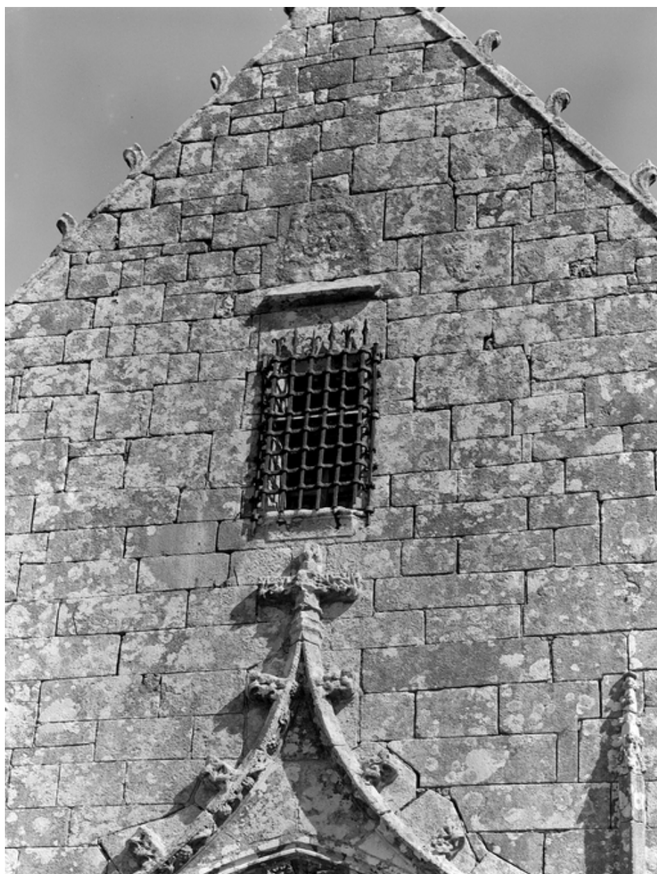
Porche, face sud : détail de la fenêtre protégée par une grille
