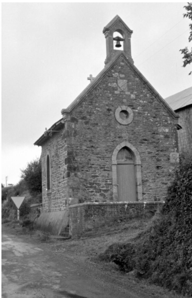
Elévation ouest : vue générale
