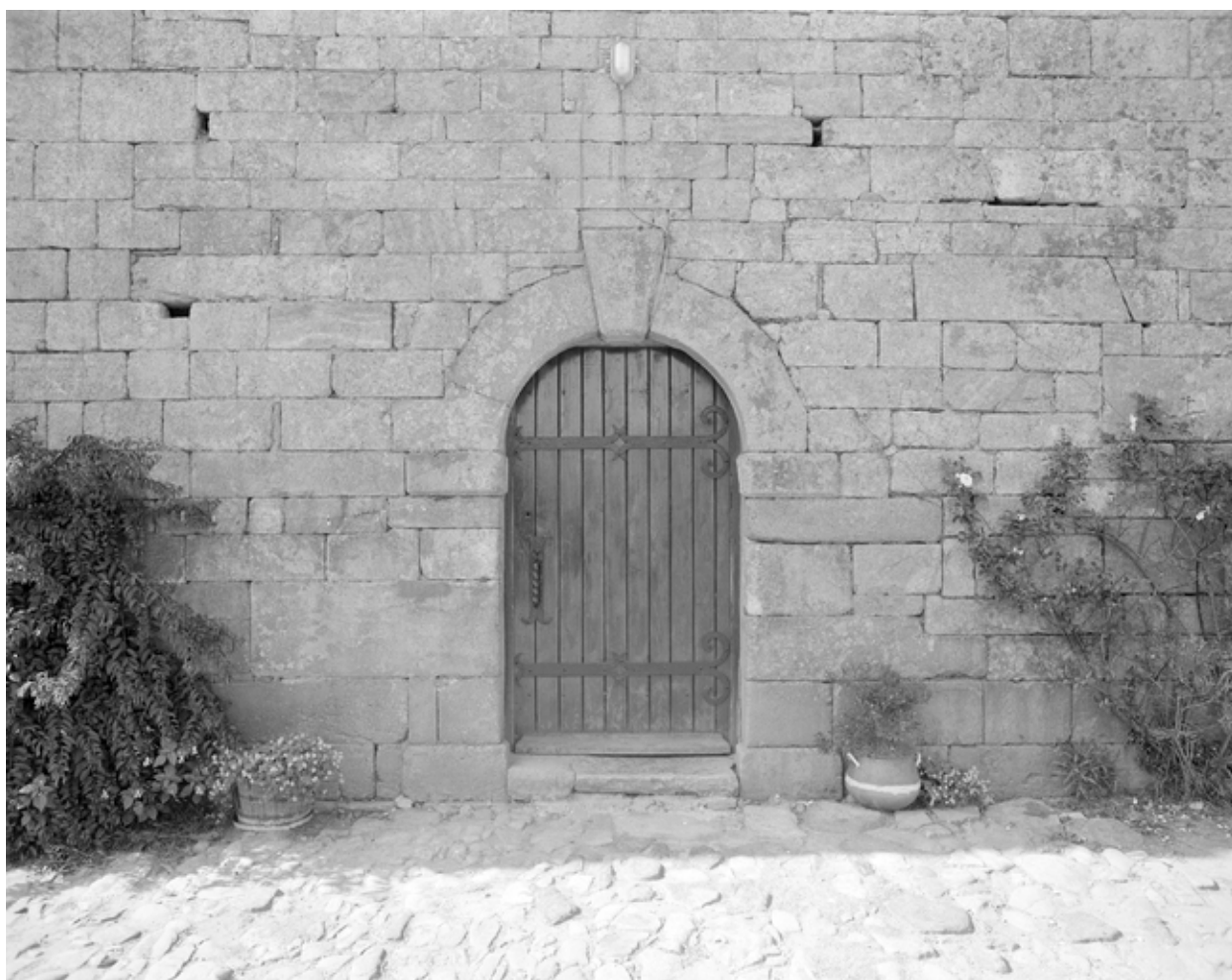
Façade sud : porte plein-cintre
